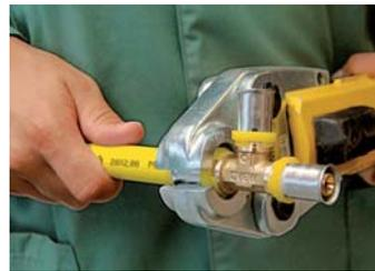
Con l'apposita pressatrice corredata di pinza di diametro corretto per lo specifico raccordo con profilo TH, chiudere la giunzione fino al completo serraggio della pinza
