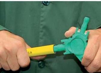
Inserire nel tubo il calibratore della misura adatta. Ruotare lo strumento premendo leggermente così da ottenere una estremità del tubo libera da bave residue, con smusso iniziale e diametro costante
